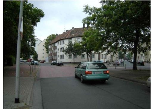
Aufpflasterungen zur Geschwindigkeitsdämpfung und Verbesserung der Überquerungsqualität (Bsp. Hannover)
