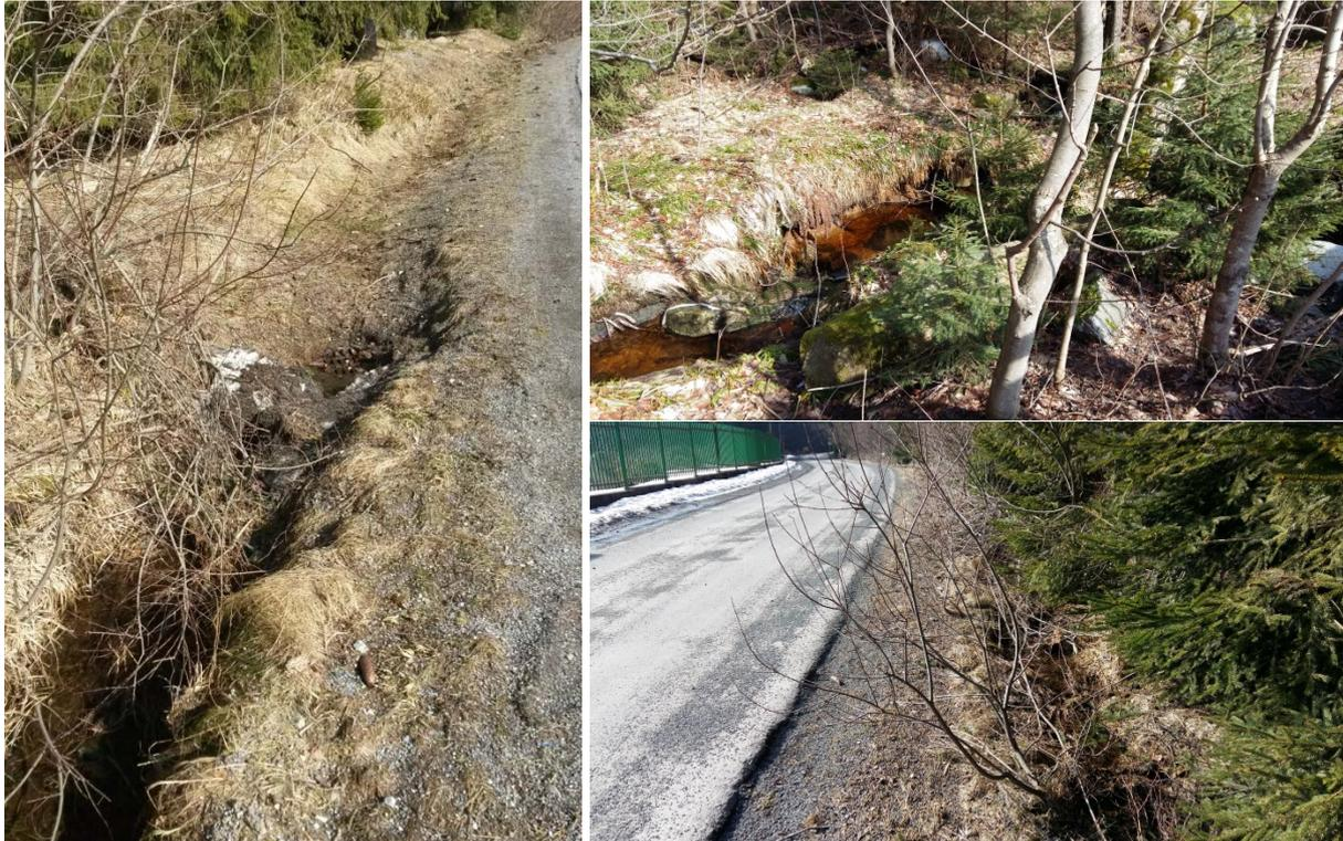
Abbildung 9: Straßenseitengraben entlang Brockenstraße zum Eingang des Nationalparkes mit sichtbarem unzureichendem Grabenprofil sowie Baum- und Strauchwerk im Abflussquerschnitt (Quelle: Steinbacher-Consult, März 2018).
