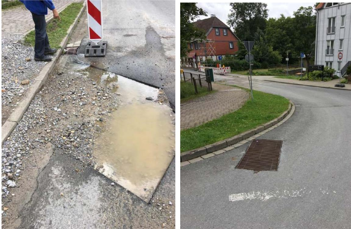
Abbildung 16: Verstopfter Durchlass in "Alter Dorfstraße" rechts mit Blickrichtung Norden und links Verrohrung Richtung "Alte Wernigeröder Straße" Blickrichtung zur Kalten Bode nach Süd (Quelle: UHV, Juli 2017).
